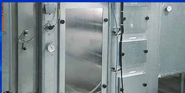
MERLIN® PURUS zabudovaný do vzduchotechnického potrubí.
